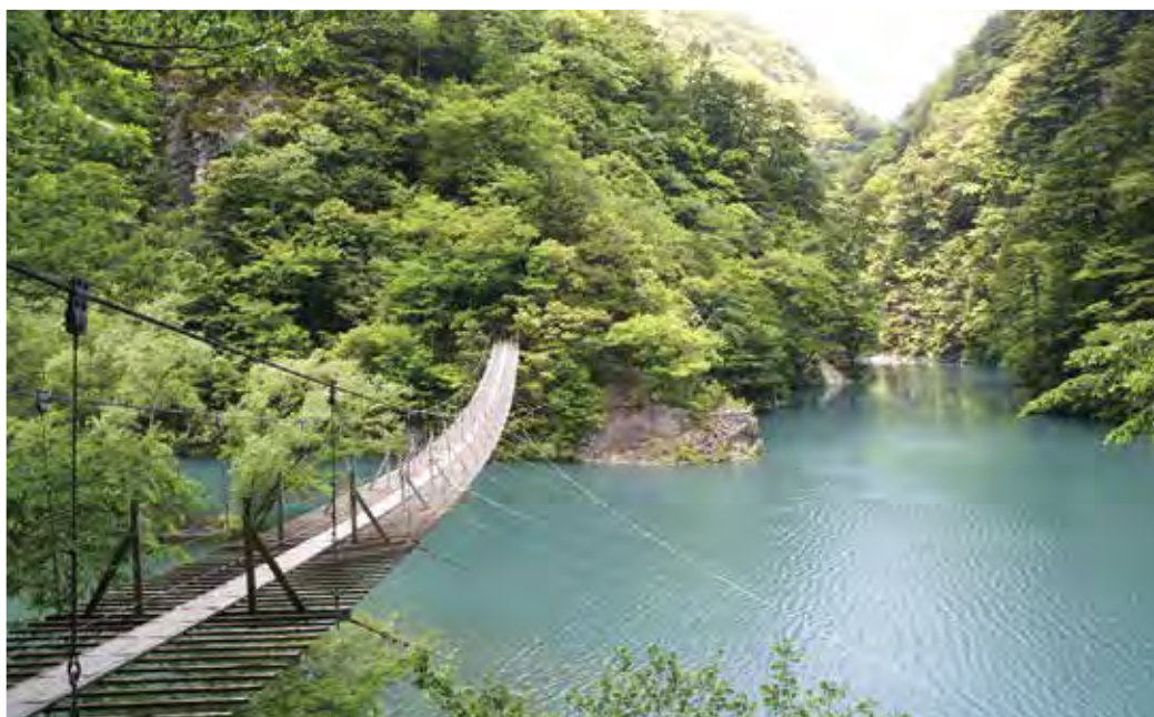
“世界の徒歩吊り橋10選” 新緑の「寸又峡 夢の吊り橋」
